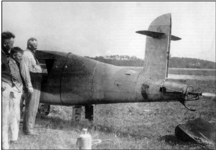
Oben: Testlauf des Sander/von Opel-Triebswerks im Rumpf der GMG II im Sommer 1929 auf der Opel Testbahn. Der sichtlich erfreute Sander steht direkt am Flugzeug. Rechts: Fritz von Opel und Friedrich W. Sander.
